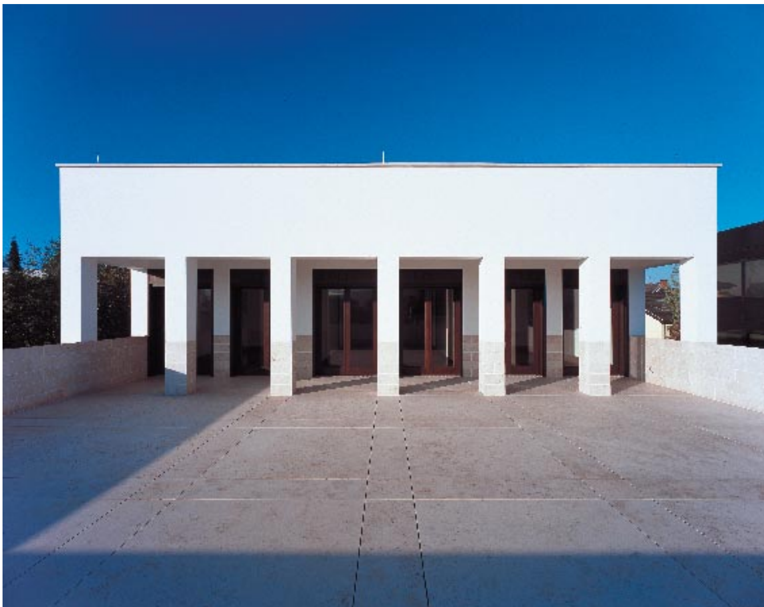
Veduta della terrazza di coronamento al secondo piano. Nella pagina a fianco: il fronte a terrazze sul giardino da sud-est; fronte d'ingresso; sezione trasversale.
